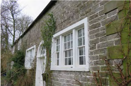
SE Elevation Entrance facade.
