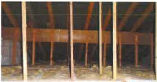
Link roof void
