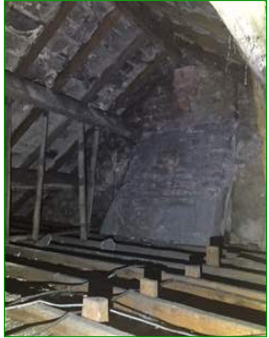
The loft void
