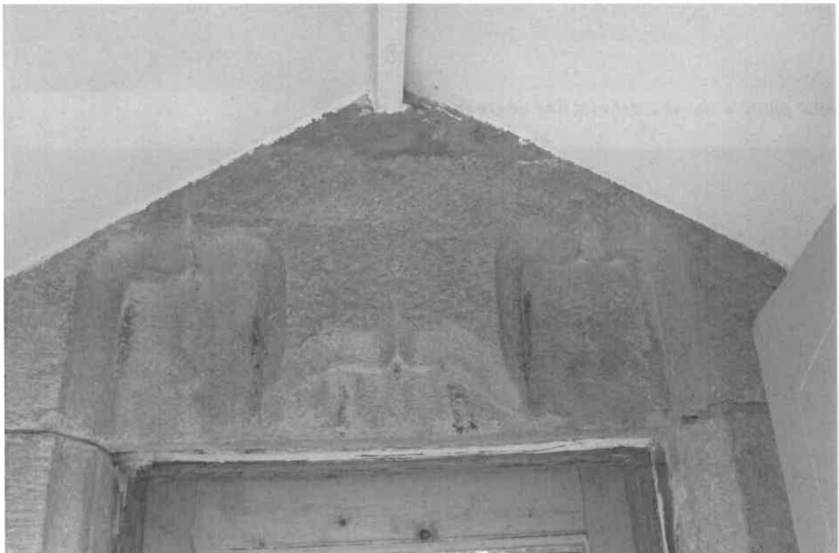
Door Lintel over front door
