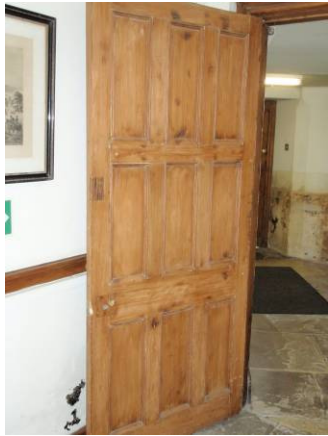
Door 10 Lobby Door
