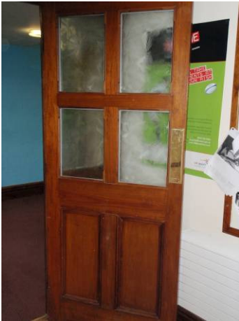
Door 19 Lobby Door
