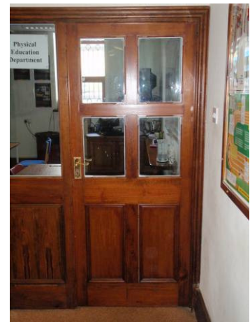
Door 18 PE Classroom
